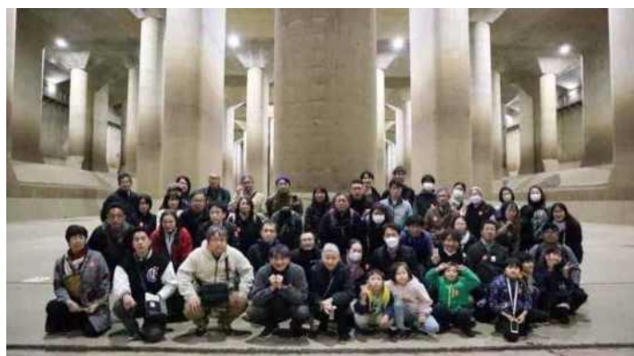
< 首都圏外郭放水路（地下神殿）の見学 >
